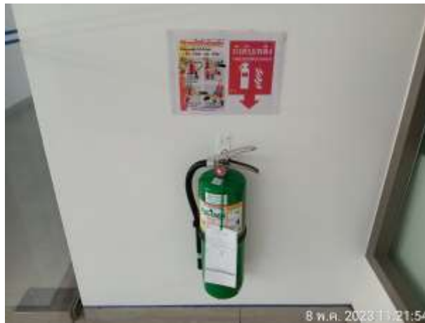
รูปที่ 2.15 ถังดับเพลิงเคมีแห้ง
